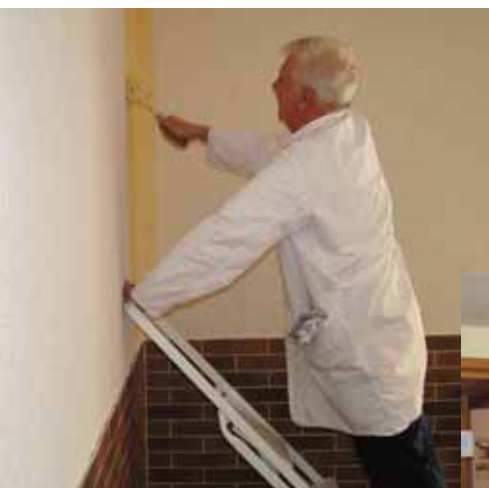
Die nicht ganz BG-konforme Nutzung einer Stehleiter.
